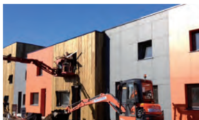
Pose de bardage à Seclin
